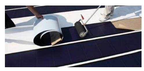
Sistema constituído por uma camada de membrana TPO (Termoplástico de Poliolefina) integrada por células fotovoltaicas flexíveis, capazes de gerar energia elétrica.
